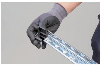
Complétez l'assemblage des échelles en insérant les embouts supérieurs de protection en PVC noir.
